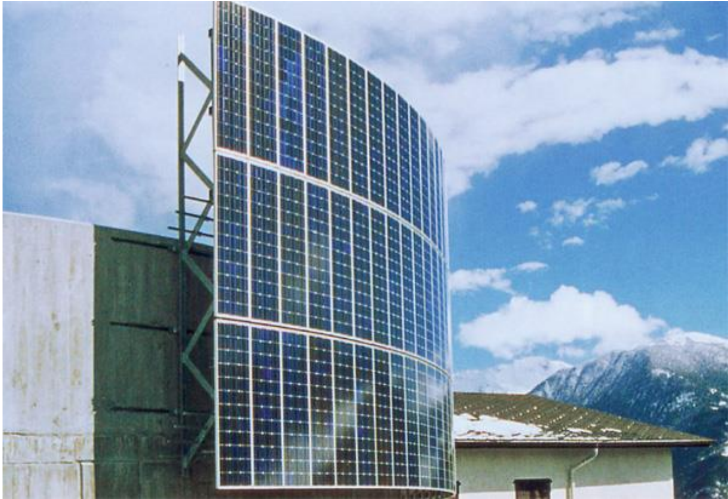
Solarverkleidung einer Garage in der Schweiz
