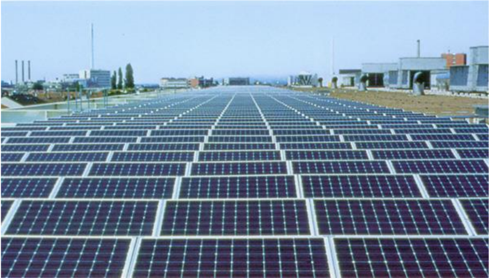
Flachdach - Messehalle Basel
