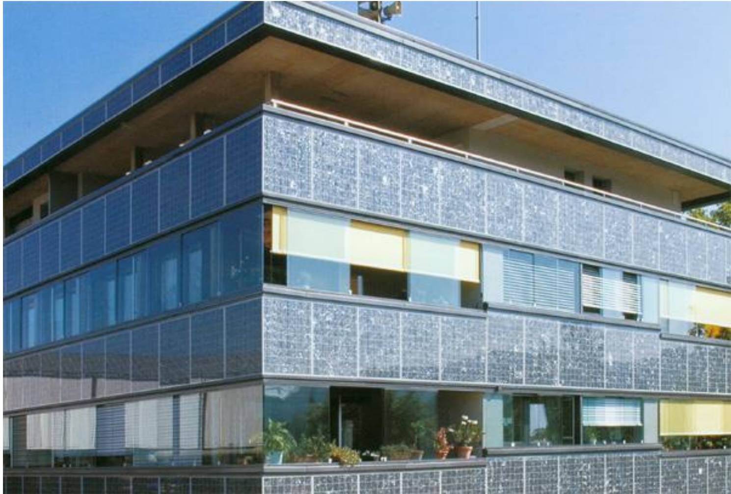
Verkleidung der Fassade mit Solarmodulen
